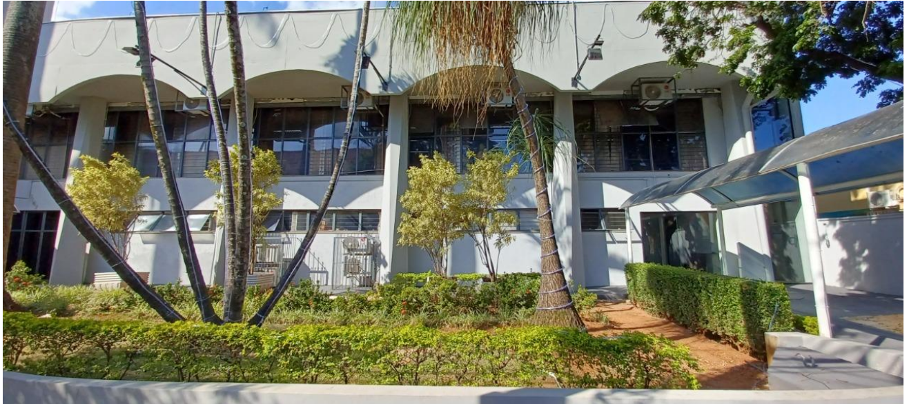
Figura 1: Fachada da Câmara Municipal de Indaiatuba - foto 01
