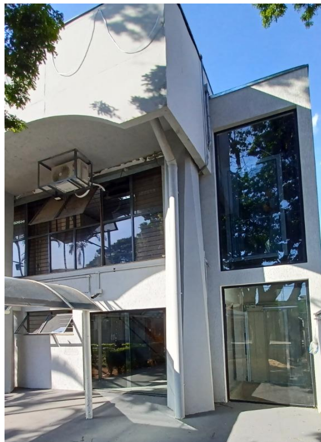
Figura 2: Fachada da Câmara Municipal de Indaiatuba - foto 02
