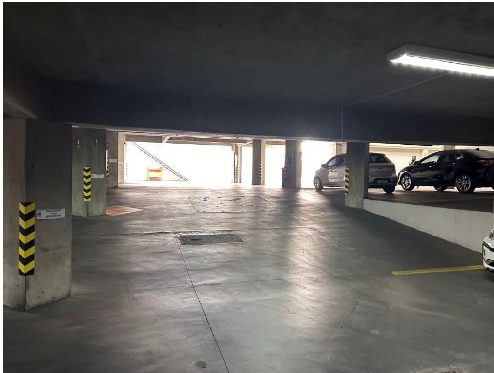
Foto 23: Vista do estacionamento coberto (a reformar)
