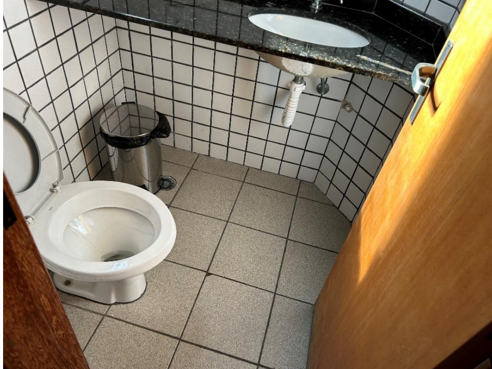
Foto 16: Vista do banheiro da diretoria (a ser reformado)
