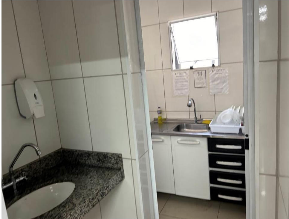
Foto 13: Vista da cozinha (a ser reformada)
