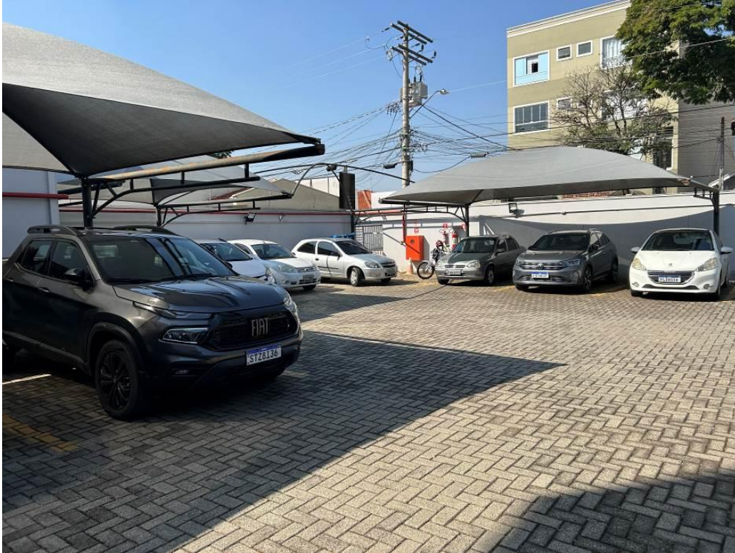
Foto 18: Vista do estacionamento descoberto (a reformar)
